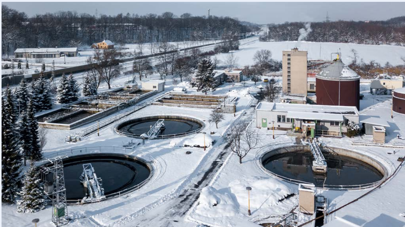
Čistírna odpadních vod Český Těšín – Dokáže vyčistit odpadní vodu pro více než 30 tisíc ekvivalentních obyvatel. Maximálně z ní může odtékat 833 kubiků vyčištěné vody za hodinu. Vyčištěná voda odtéká do Olše.
