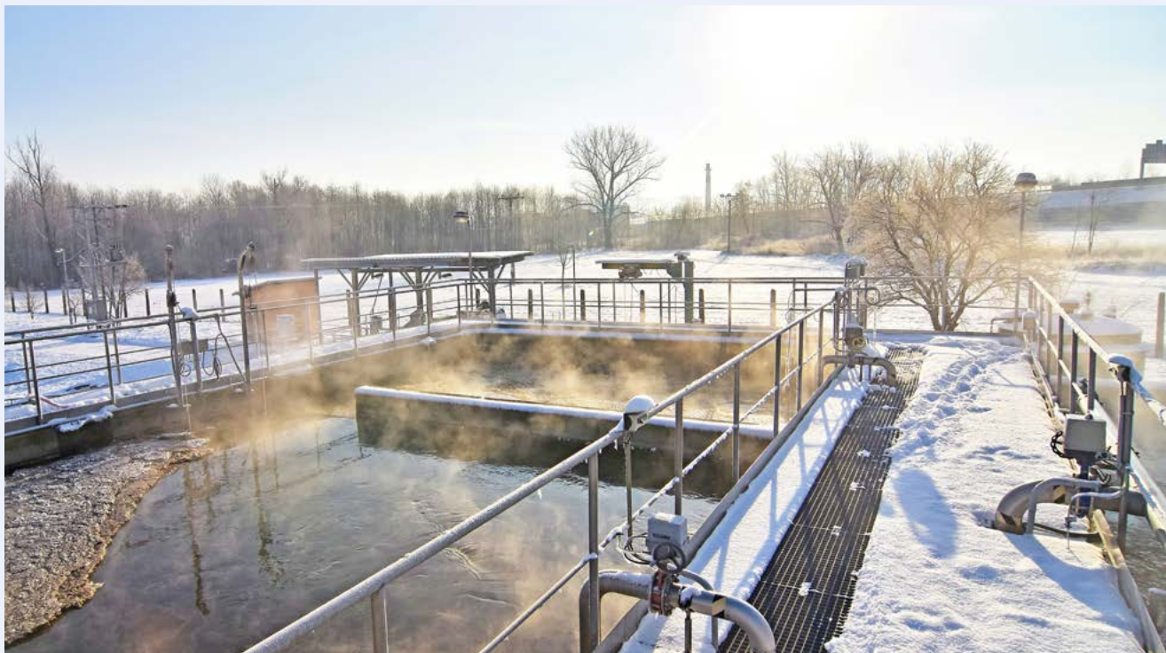
Čistírna odpadních vod v Příboře - Mrazivý východ slunce nad čistírenským provozem. Za rok dokáže vyčistit více než 1,3 milionu m 3 odpadních vod, což představuje ekvivalent pro 11 tisíc obyvatel.
