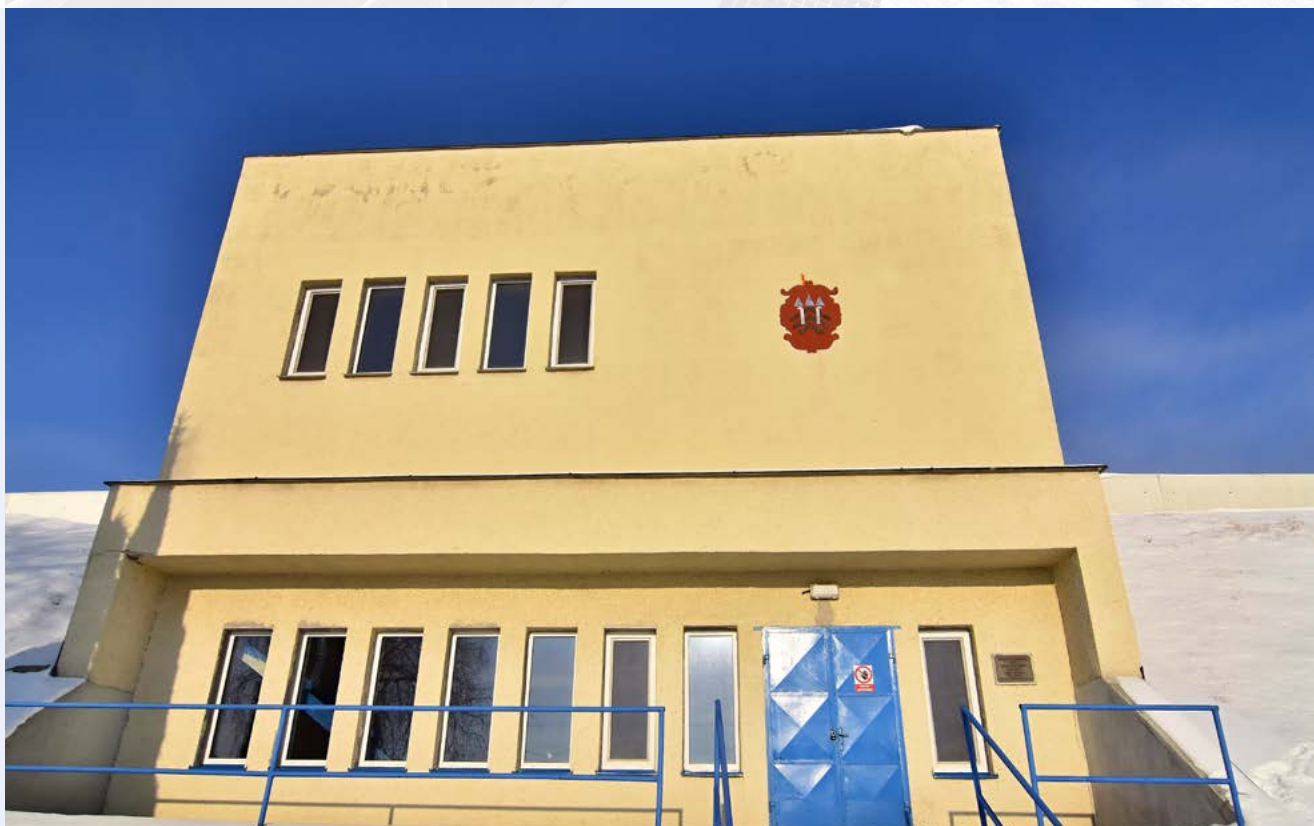
Vodojem v Příboře - Dvoukomorový zemní vodojem nad městem a rychlostní silnicí D48 má celkovou kapacitu 2000 m 3 pitné vody.
